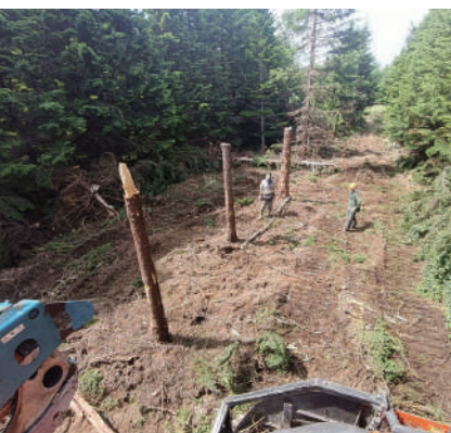
時には重機の手も借りる
