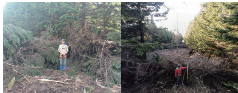
間伐材を1.5m積み上げて、丸太の間に枝を詰め込んだ間伐材防鹿柵。柵の高さを低くすることで、これまでより広い範囲を囲むことが可能に。
