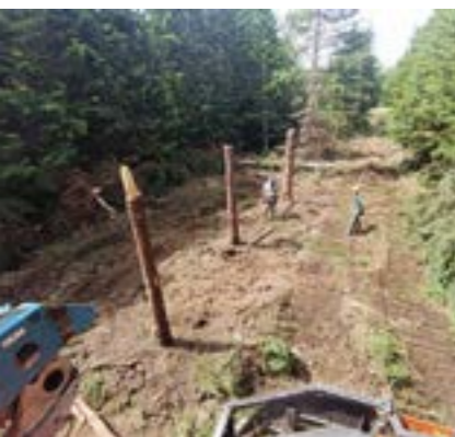
時には重機の手も借りる
