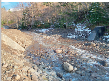
■ 改修工事後の治山ダム。
