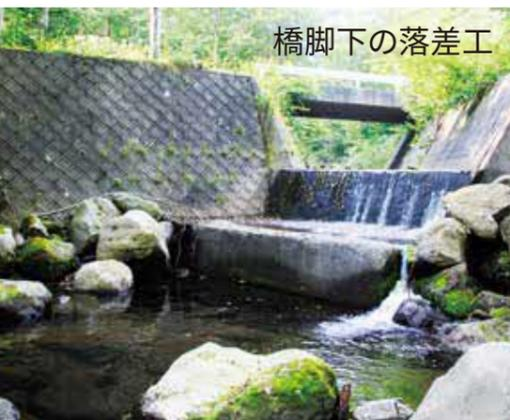
■ 落差工の下にはオシヨロコマやヤマメの姿が確認されている(上)。測量中の専門家(下)。簡易魚道はある程度の増水にも耐えられる構造で設計します。
