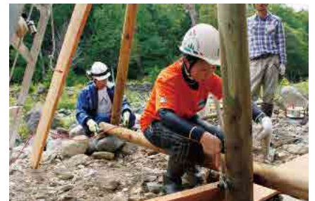
三角形はボルトナットで固定。柱を押さえる人、レンチを使って締める人など、それぞれに役割を決めて作業します。
