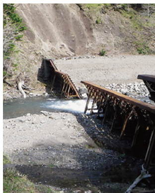
写真左／改修前の岩尾別川支流赤イ川の鋼製ダム。写真右／2010年、スリット(切り込み)が施され、上流へ魚の遡上が可能となった。
