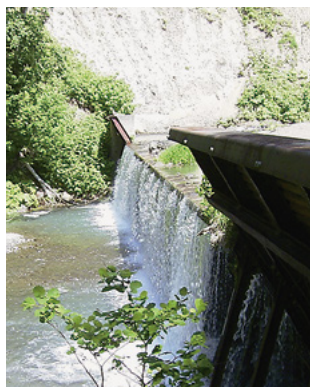
写真左／改修前の岩尾別川支流赤イ川の鋼製ダム。写真右／2010年、スリット(切り込み)が施され、上流へ魚の遡上が可能となった。
