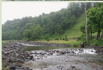
写真上／改修前の岩尾別川。写真下／2012年、魚の環境改善を目的に、岩石を配置し、瀬と淵の形成を行った。
