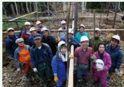
大きな苗木を支える柱も全て自分たちで立てる。
