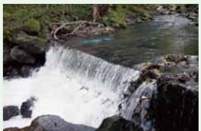
改修前①と改修後②の岩尾別川の河川工作物。ダム段差が解消され、サケやマスが上流まで遊べるようになった。
