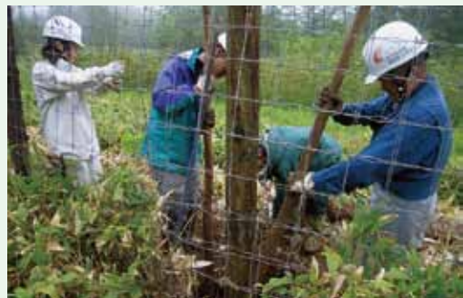
小雨の中での防鹿柵修繕作業。掘る人、打つ人、支える人分業して効率的に作業を進める。
