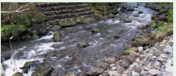
改修前①と改修後②の岩尾別川の河川工作物。ダム段差が解消され、サケやマスが上流まで遊べるようになった。
