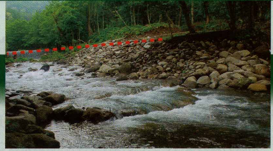
平成18年(2006)、北海道森林管理局によって改修された岩尾別川支流の河川工作物。赤線はかつてのダムの高さ。
