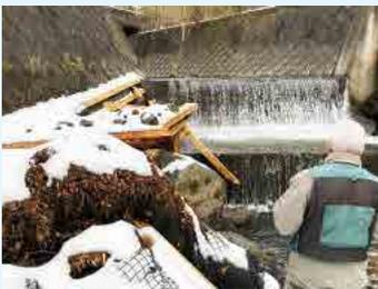
設置後すぐに記録的な大雨によって半壊した盤ノ川の魚道。増水時の水圧がかかる魚道上部を石積みにする等、強固な構造へ再設計して修繕する計画が進められています。
