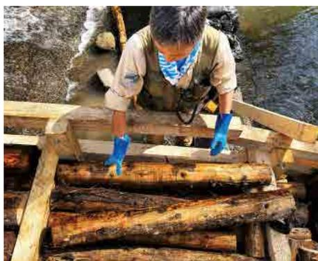
■魚道の土台に間伐材を用いました。なお、製材時に発生する辺材もチップにして、余すところなく活用しています。
