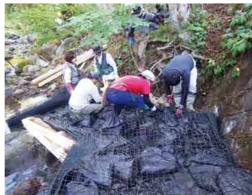
■骨組みの中に丸太と土嚢を敷き詰めて丈夫な土台が完成。
